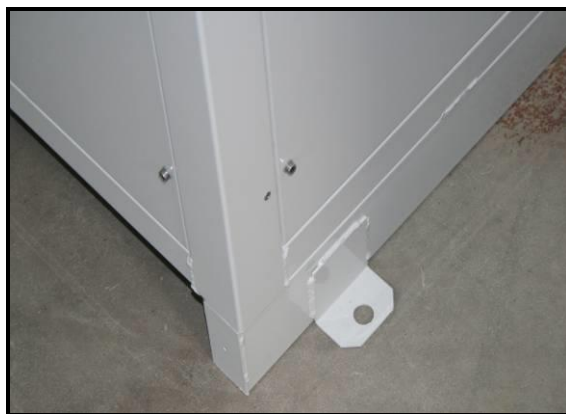
Fig. 8.- Agujeros de anclaje exterior
