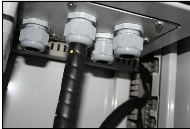
Fig. 16.- Prensaestopas para cables de maniobra
