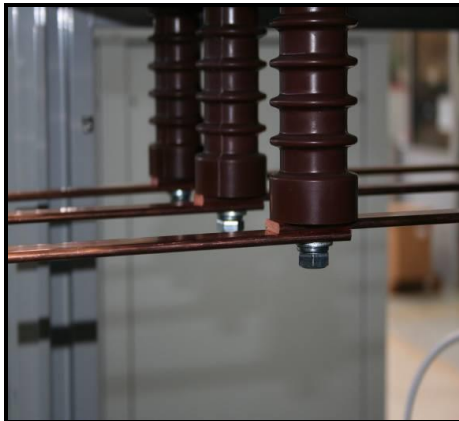
Fig. 15.- Pletinas de conexión entre módulos
